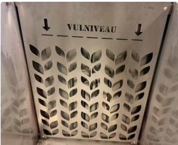
Duidelijk lasergravure 'Vulniveau' aan de binnenzijde ter voorkoming van overstroming.
